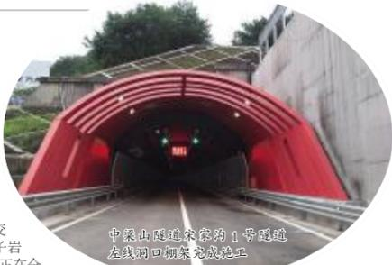
中梁山隧道扩容的1号隧道在洞口加架完成施工
